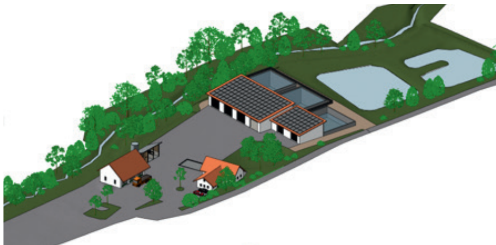
Die derzeitige Kläranlage vom Typ einer Teichanlage ist auf 2500 Einwohnergleichwerte ausgelegt. Die Auslastung mit dem Bau einer SBR-Anlage verdoppelt sich. Foto: VG Ergoldsbach
