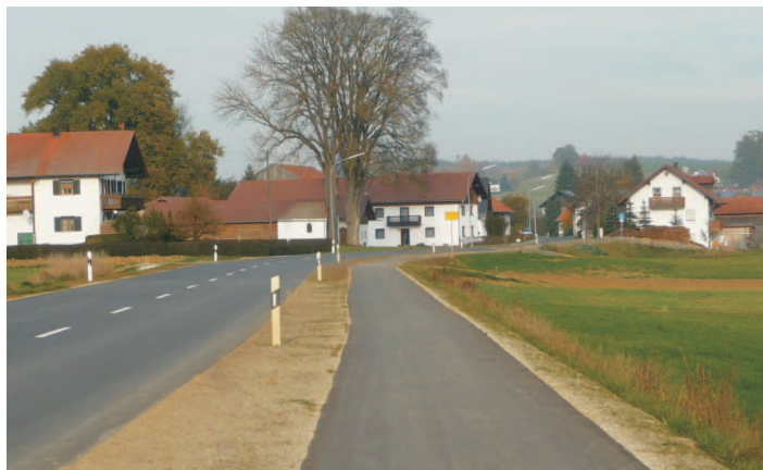
Fuß- und Radweg errichtet. Der Grund für den Radweg wurde von der Gemeinde bereitgestellt.
